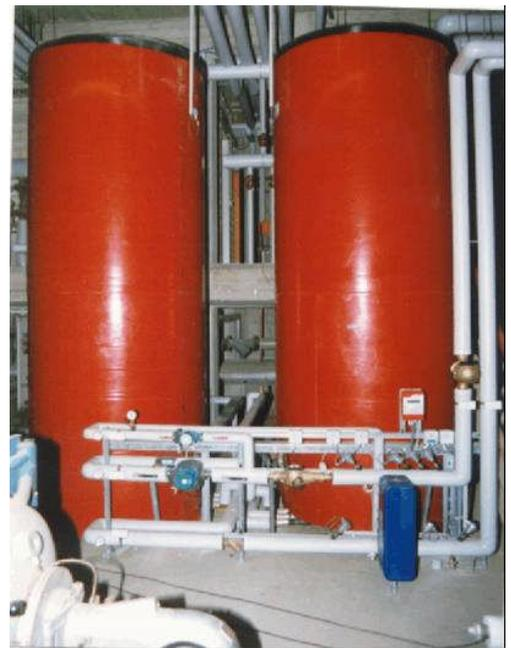
Abbildung 1: Kollektorfeld (131 m<sup>2</sup>) und Solarpufferspeicher (2 x 4 m<sup>3</sup>)
