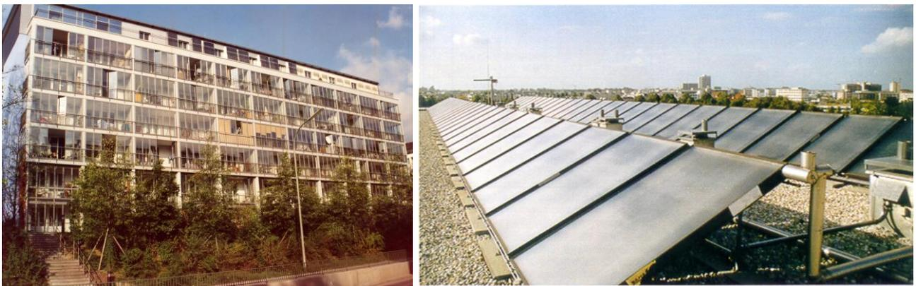
Abbildung 1: Mehrfamilienhaus und Kollektorfeld (109 m<sup>2</sup>) auf dem Flachdach des Gebäudes
