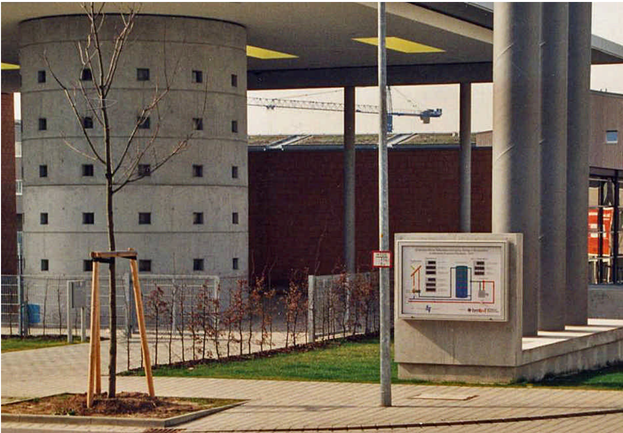
Bild 11: Anzeigetafel vor der unterirdischen Heizzentrale in Stuttgart-Burgholzhof (linker runder Bau mit Glasbausteinen: über die Heizzentrale hinausragender Teil des solaren Pufferspeichers)
