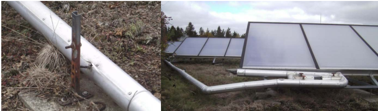
Abbildung 6: Abgerostete Rohrbefestigung und dadurch verbogene Verrohrung
