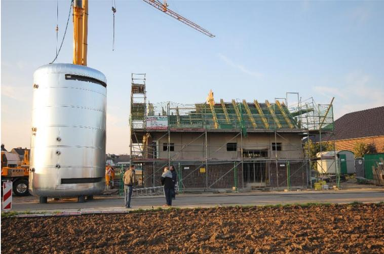
Abb. 1: Einbringung des Wärmespeichers
