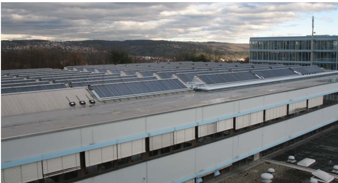
Bild 1: Ansicht des Gebäude in Esslingen
