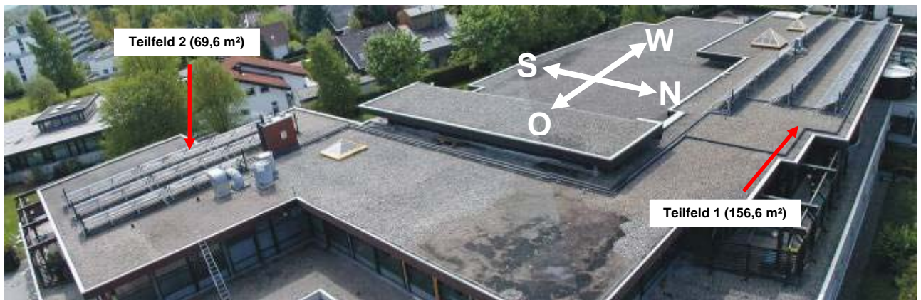
Bild 3.2: Dach der Albtherme Waldbronn mit den zwei Kollektor-Teilfeldern
