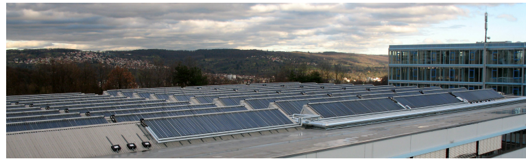
Solare Kälteerzeugung Festo AG & Co. KG Esslingen (1330 m 2 )
