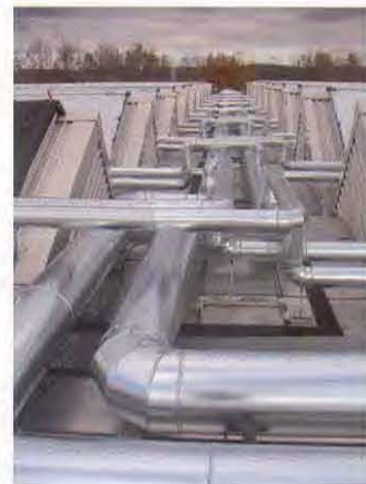
Abb. 2: Verrohrung zwischen den Kollektoren vor Inbetriebnahme. Die Kollektoren sind noch abgedeckt
