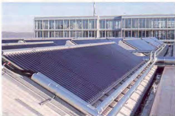
Abb. 1: Teil des Kollektorfeldes und des Nachbargebäudes, das mit Solarwärme und -kälte versorgt wird. (Quelle: Festo)
