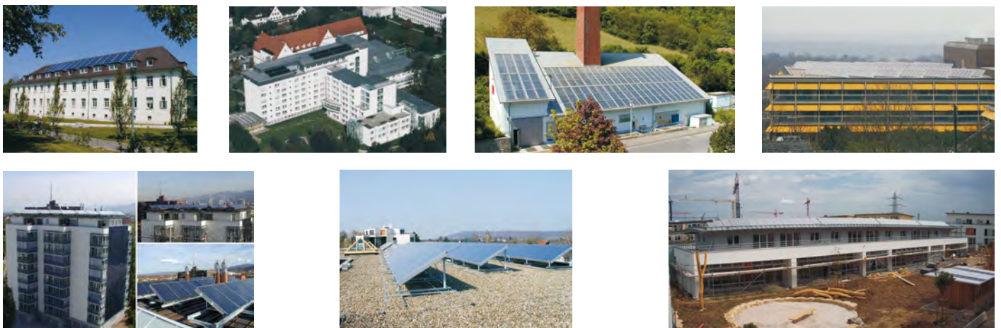
Abb. 1: v. l. n. r. Studentendorf Vauban (143 m 2 ), Kreiskrankenhaus Mindelheim (120 m 2 ), Hegau-Klinikum Singen (264 m 2 ), Stadtklinik Baden-Baden (276 m 2 ), Wohngebäude Wilmersdorferstr. (228 m 2 ), Albtherme Waldbronn (226 m 2 ), Nahwärme Holzgerlingen (249 m 2 ).
