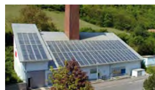
Hegau-Klinikum Singen (Kollektorfläche: 264 m 2 )
