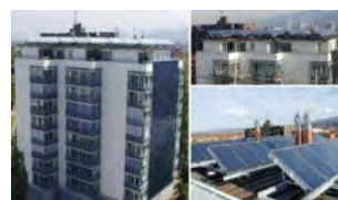
Wilmsdorferstraße Freiburg (Kollektorfläche: 228 m 2 )
