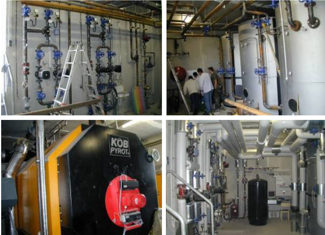
Bild 3.4: Blick in die Heizzentrale während der Montage und nach Fertigstellung
