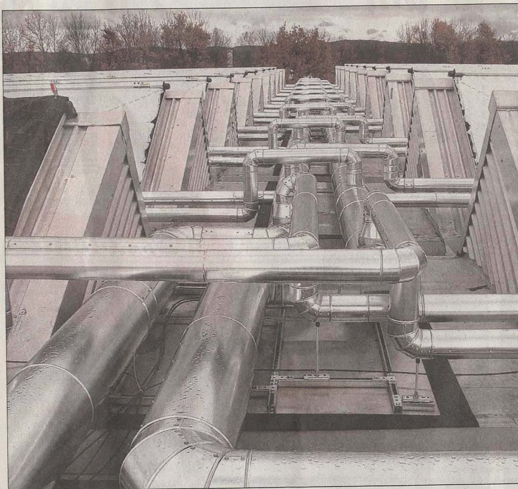
VOLLES ROHR: Das weltweit größte Vakuumröhren-Kollektorfeld als Wärmequelle ist in Esslingen zu bewundern. Mit der Solaranlage wird nicht nur beheizt, sondern auch gekühlt. Foto: Hochschule Offenburg
