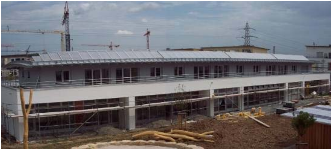
Bild 1: Ansicht Gebäude in Holzgerlingen
