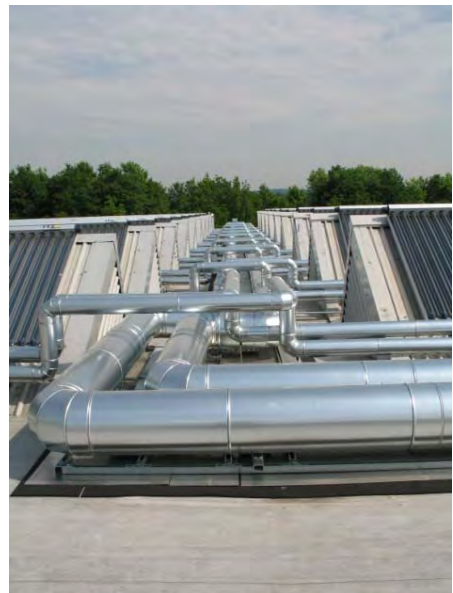
Bild 3.2: Detailansicht eines Teilkollektorfeldes und der Verrohrung zwischen den Teilfeldern
