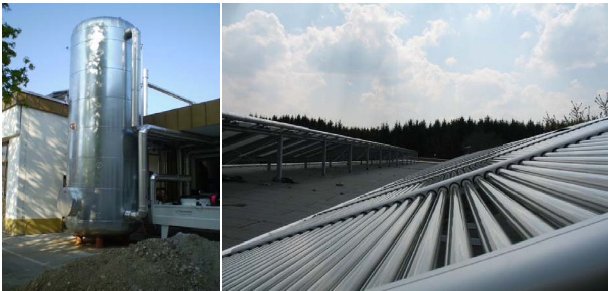
Bild 3.2 Solar-Pufferspeicher links und Detailansicht Kollektorfeld der solare Klimatisierungsanlage Rottweil rechts
