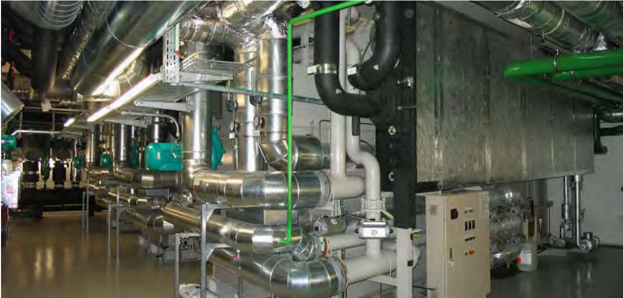
Bild 3.1: Blick in die Kältezentrale (AdKMs rechts)
