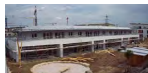
Nahwärmenetz Holzgerlingen (Kollektorfläche: 249 m 2 )
