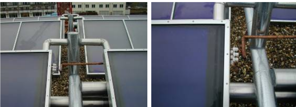
Bild 3.3: Detailansicht der Verrohrung von Kollektoren und Kollektortemperaturfühler
