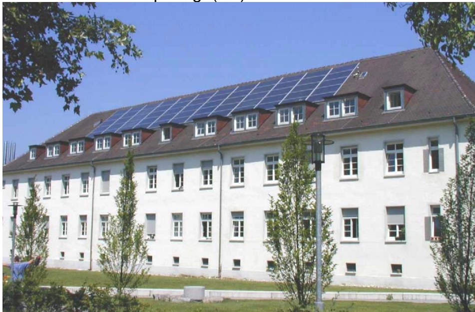
Bild 1: Gebäude 14 des Studentendorfs in Freiburg-Vauban
