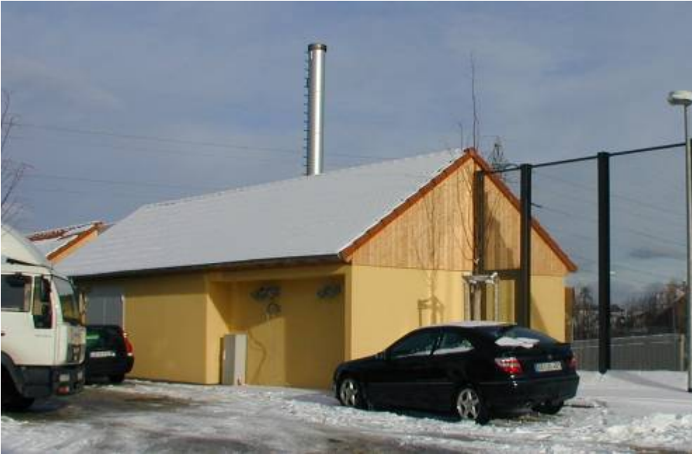
Bild 3.1: Heizzentrale der Nahwärmeversorgung Holzgerlingen
