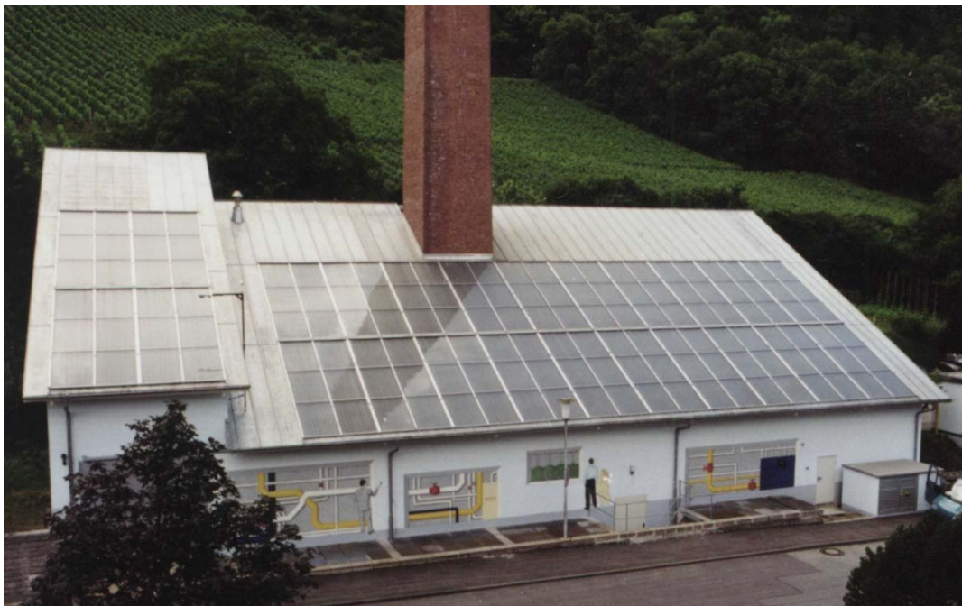
Bild 1: Heizzentrale des Hegau-Klinikums Singen mit Dachintegriertem Kollektorfeld
