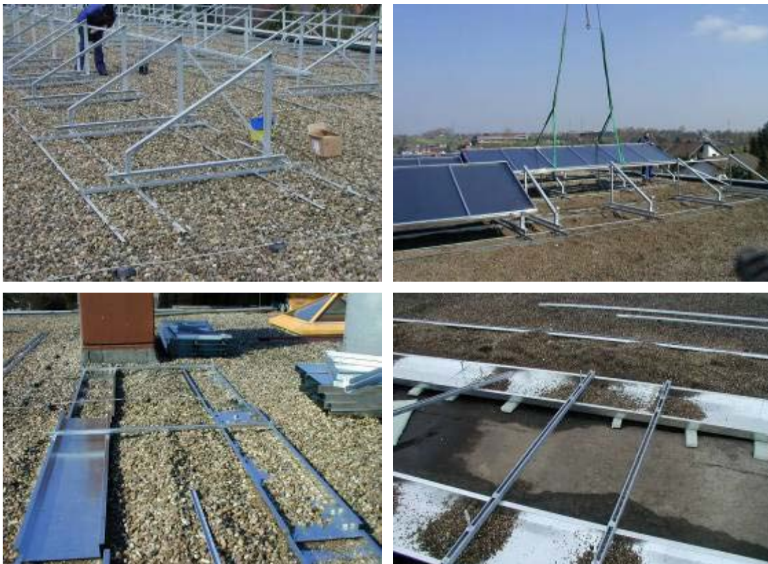
Bild 3.4: Kollektor-Unterkonstruktion und Kollektormontage
