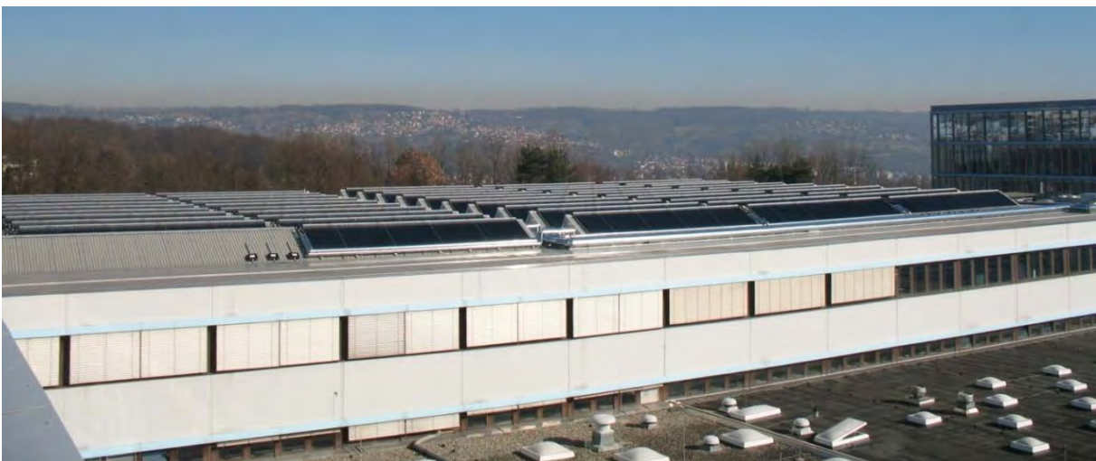
Bild 3.3: Kollektorfeld der solaren Klimatisierung der Festo AG & Co. KG in Esslingen
