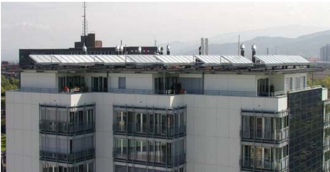
Bild 1: Ansicht Gebäude in der Wilmersdorfer Straße in Freiburg
