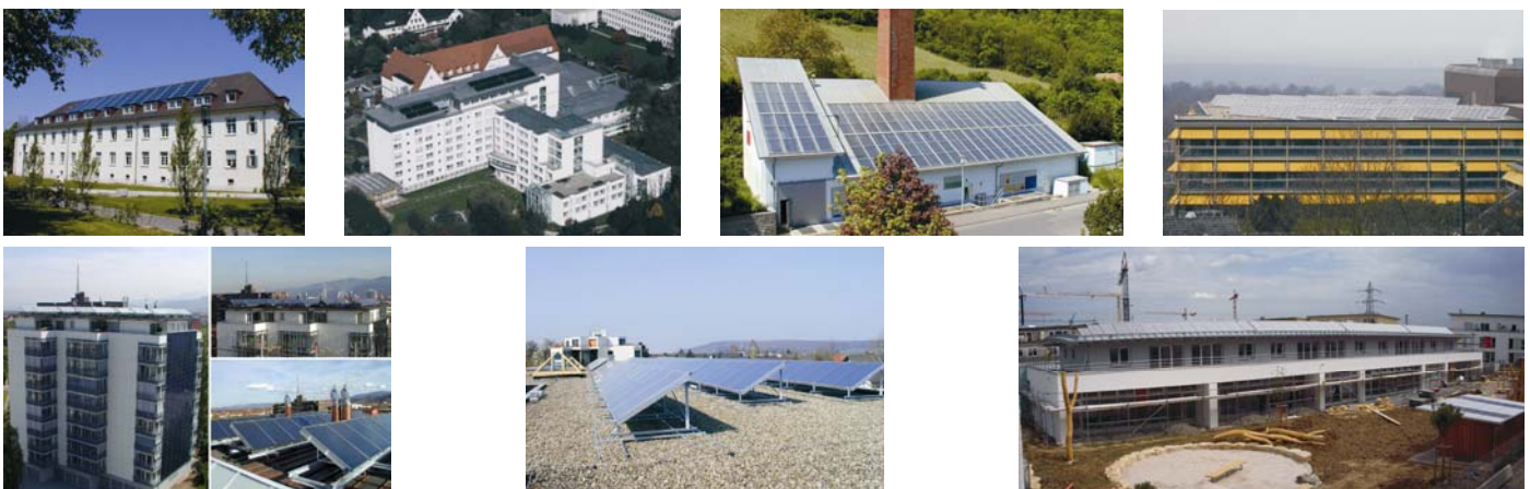
Abb. 1: v. l. n. r. Studentendorf Vauban (143 m 2 ), Kreiskrankenhaus Mindelheim (120 m 2 ), Hegau-Klinikum Singen (264 m 2 ), Stadtklinik Baden-Baden (276 m 2 ), Wohngebäude Wilmersdorferstr. (228 m 2 ), Albtherme Waldbronn (226 m 2 ), Nahwärme Holzgerlingen (248 m 2 ).
