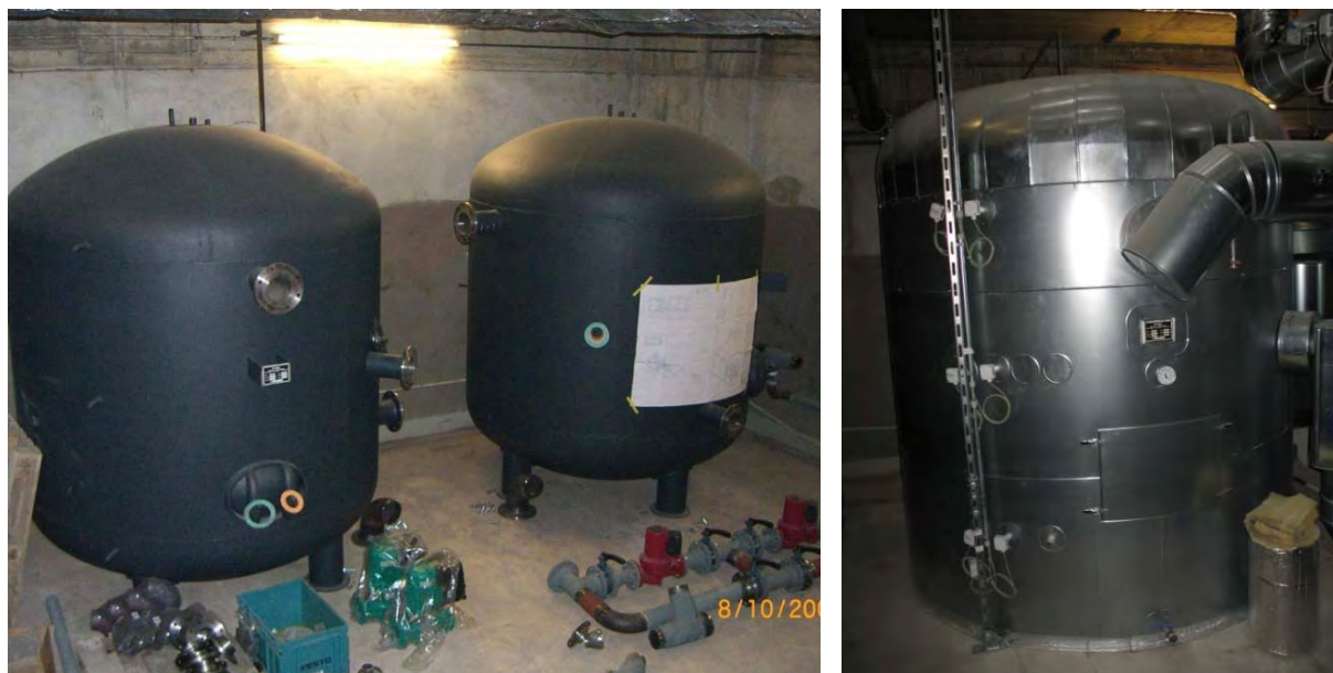
Bild 3.4: Blick in die Solarzentrale während der Montage und nach Fertigstellung der Solarspeicher
