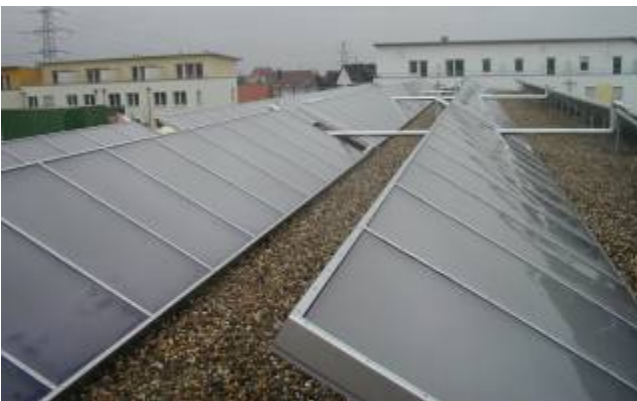
Bild 3.2: Kollektorfeld auf dem Dach des Kindergartens
