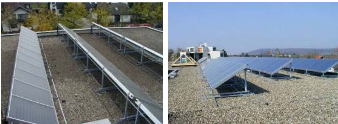
Bild 3.3: Detailansicht Kollektor-Teilfeld 1 (links) und Teilfeld 2 (rechts)
