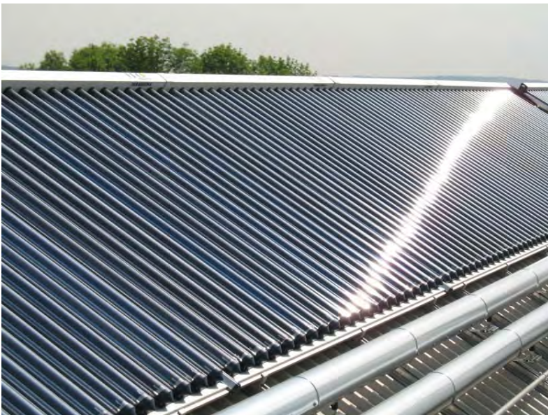
Bild 3.2: Detailansicht eines Teilkollektorfeldes und der Verrohrung zwischen den Teilfeldern
