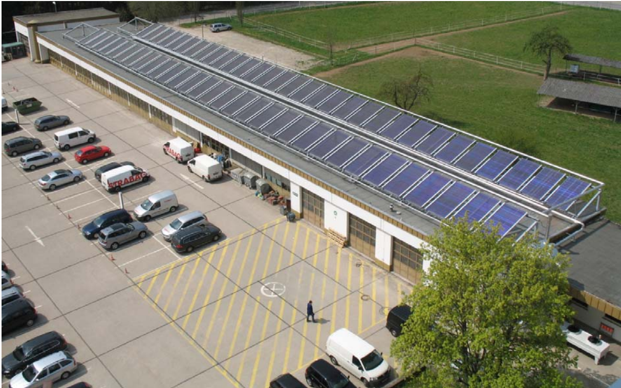
Bild 3.1: Kollektorfeld der solaren Klimatisierungsanlage Rottweil auf dem Werkstattgebäude. Rechts unten ist der Notkühler zu sehen.
