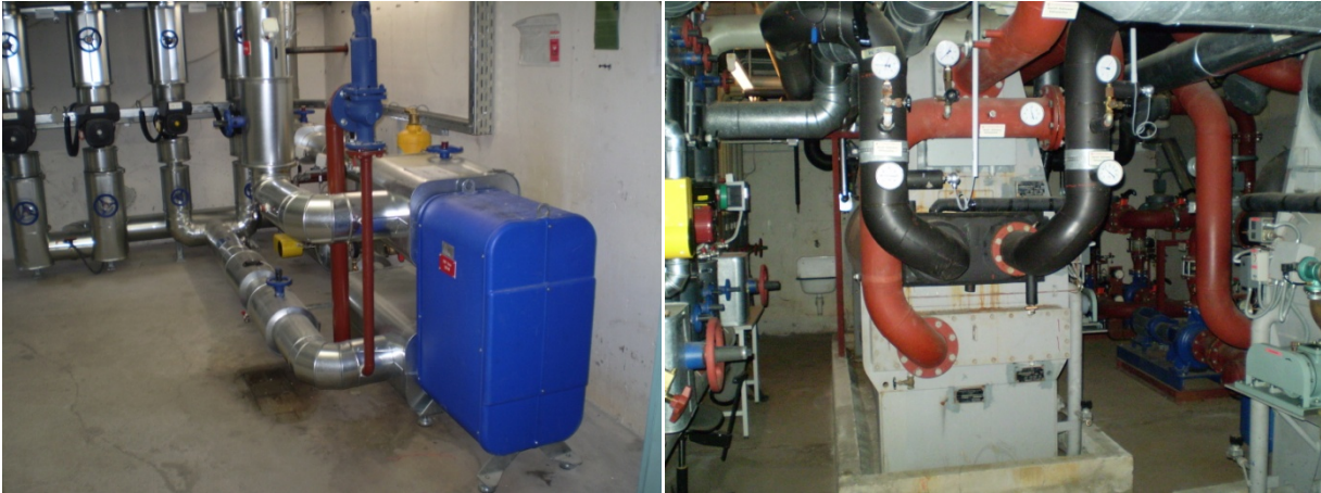
Bild 3.3 Links: Wärmeübertrager zwischen Kollektorkreis und Speicherladekreis. Rechts: Absorptionskältemaschine
