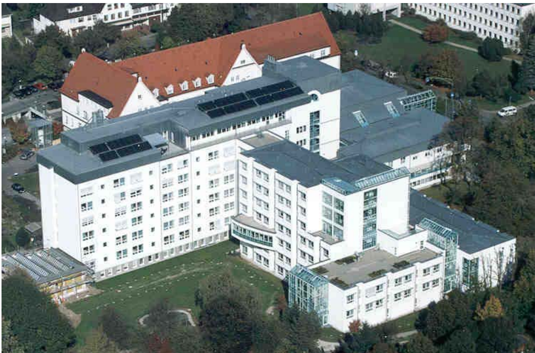
Bild 1: Ansicht des Kreiskrankenhauses Mindelheim mit den Solarkollektoren auf dem Dach
