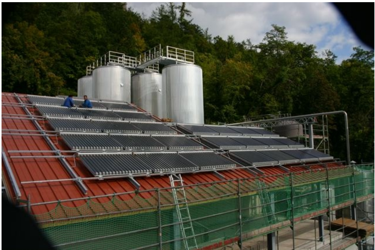
Abb. 25: Errichtung des Teilfeldes 1 auf dem Dach der neuen Produktionshalle
