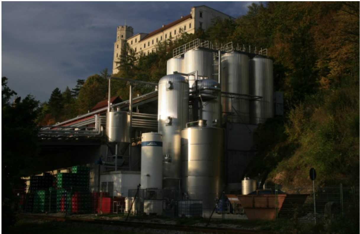
Abb. 26: Ansicht der beider 55 m³ Solarpufferspeicher
