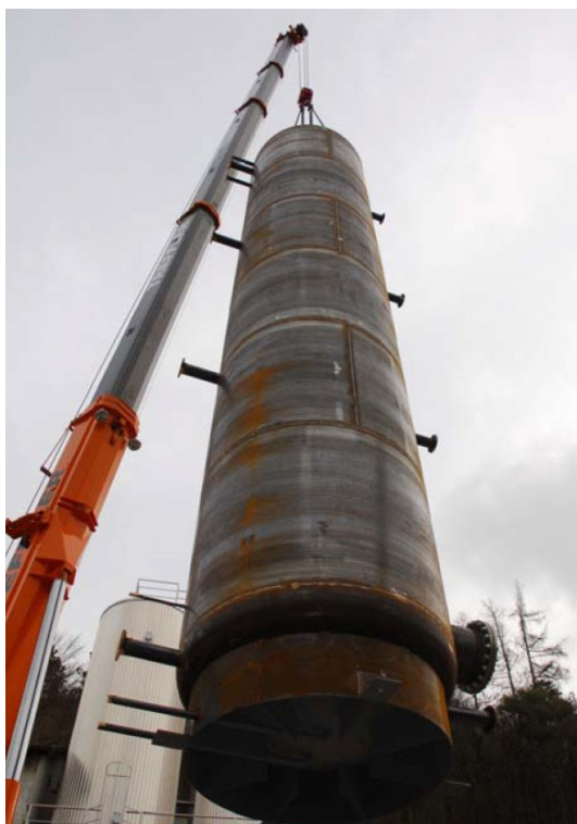
Abb. 27: Aufstellung der Pufferspeicher im April 2008
