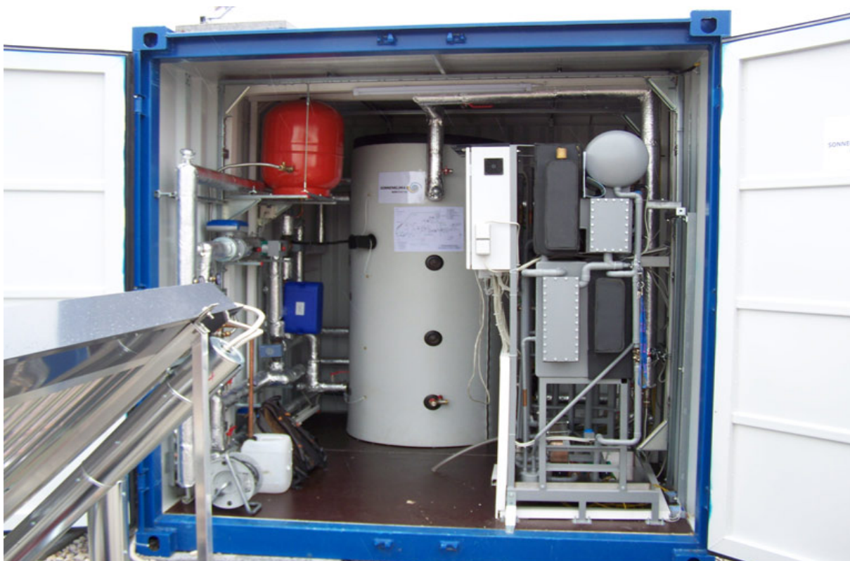
Abb. 4: Ansicht des Technikcontainers mit Pufferspeicher, Absorptionskältemaschine und Steuerung
