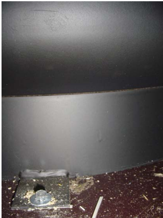
Abb. 14: ungedämmter Speicherboden
