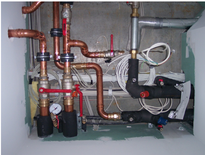
Abb. 63: Bsp.: Diese Stelle oberhalb einer Deckenluke ist in einem konkreten Projekt der einzig zugängliche Einbauort für eine Durchflussmessung
