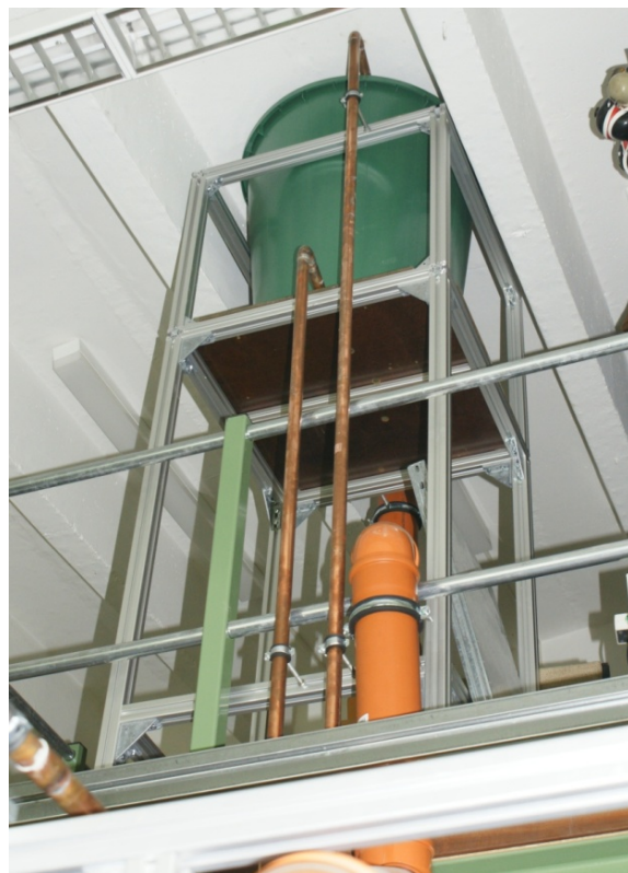
Abb. 65: Ansicht des Hochbehälters mit Überlauf (orangenes PEHD-Rohr)
