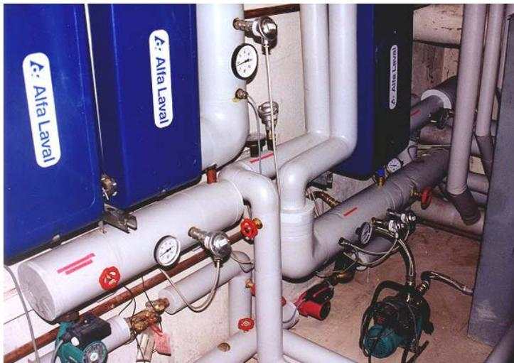
Abb. 008 Details der Solartechnik im Keller (Wärmetauscher) (Foto: TU Ilmenau FG TFD 2000)
