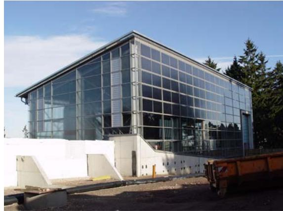
Abbn. 025 Ansicht der Südfassade des Heizhauses mit den installierten Kollektoren
