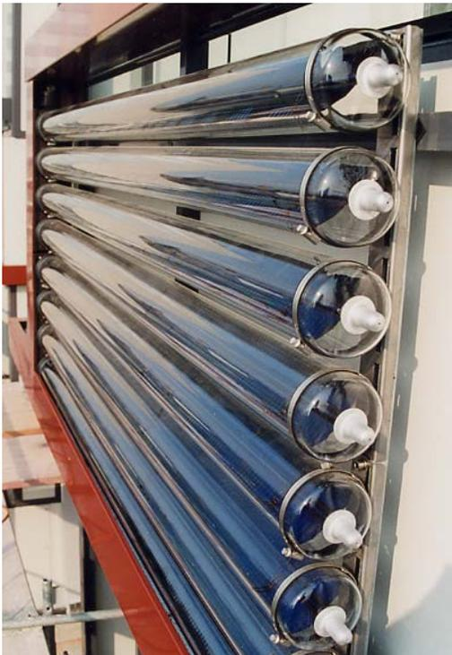
Abb. 018 Teilansicht eines montierten Balkonmoduls. Die Verkleidungen sind teilweise entfernt.
