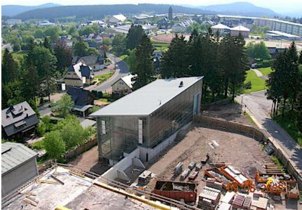
Abb. 030 Ansicht des Heizhauses von oben mit den installierten Kollektoren
