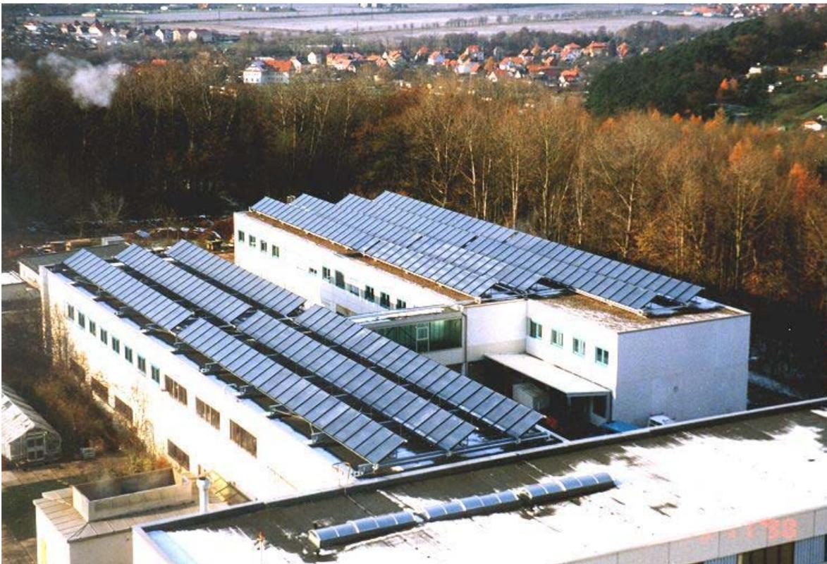
Abb. 009 Gesamtansicht des Kollektorfeldes auf dem Dach der Technischen Versorgung und der Apotheke (Foto: TU Ilmenau 2000 / Abb. 009 mit freundlicher Genehmigung durch Ing.-Büro für Licht- und Solartechnik Sondershausen)
