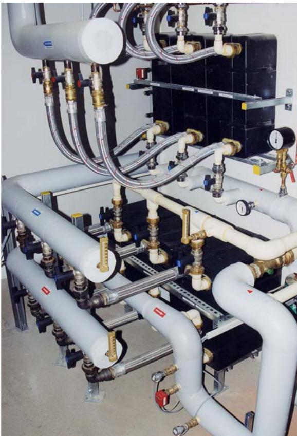
Abb. 020 Vorwärmetauscher. Darüber befinden sich die Wärmetauscher für die Nachheizung. (Foto: TU Ilmenau FG TFD 2001)
