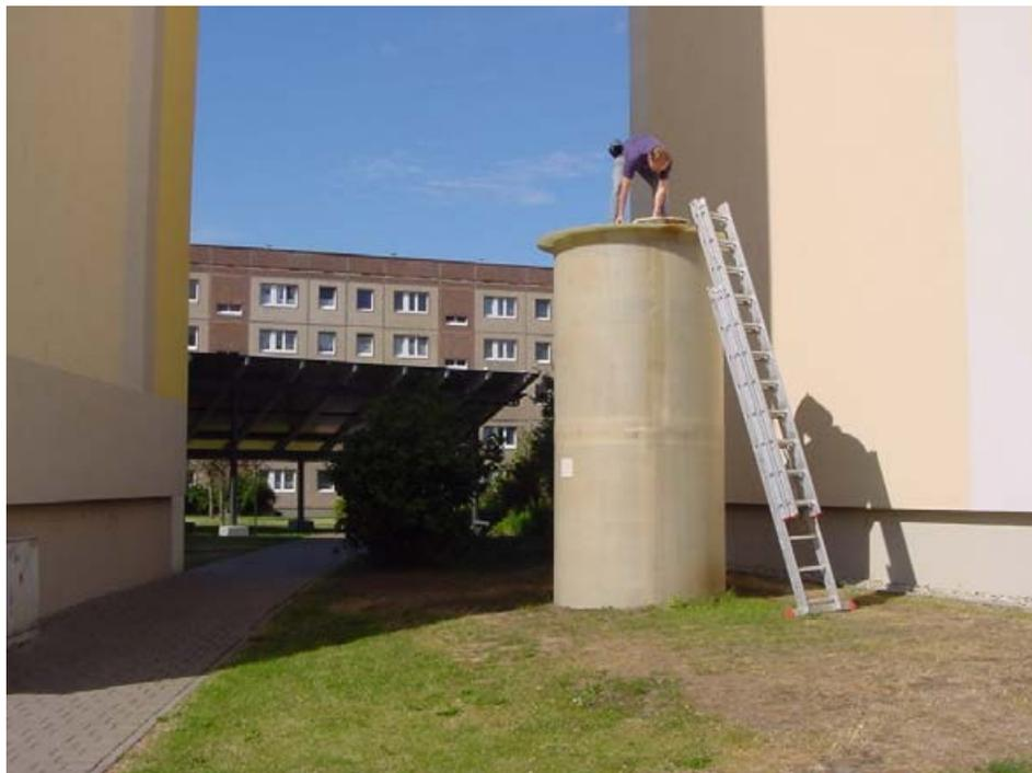
Abb. 022 Ansicht des im freien aufgestellten GFK-Wärme-Pufferspeichers
