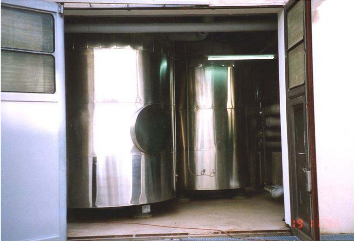
Abb. 010 Ansicht der isolierten Solar-Pufferspeicher im Technikraum der Technischen Versorgung ( Foto: TU Ilmenau FG TFD 2000)
