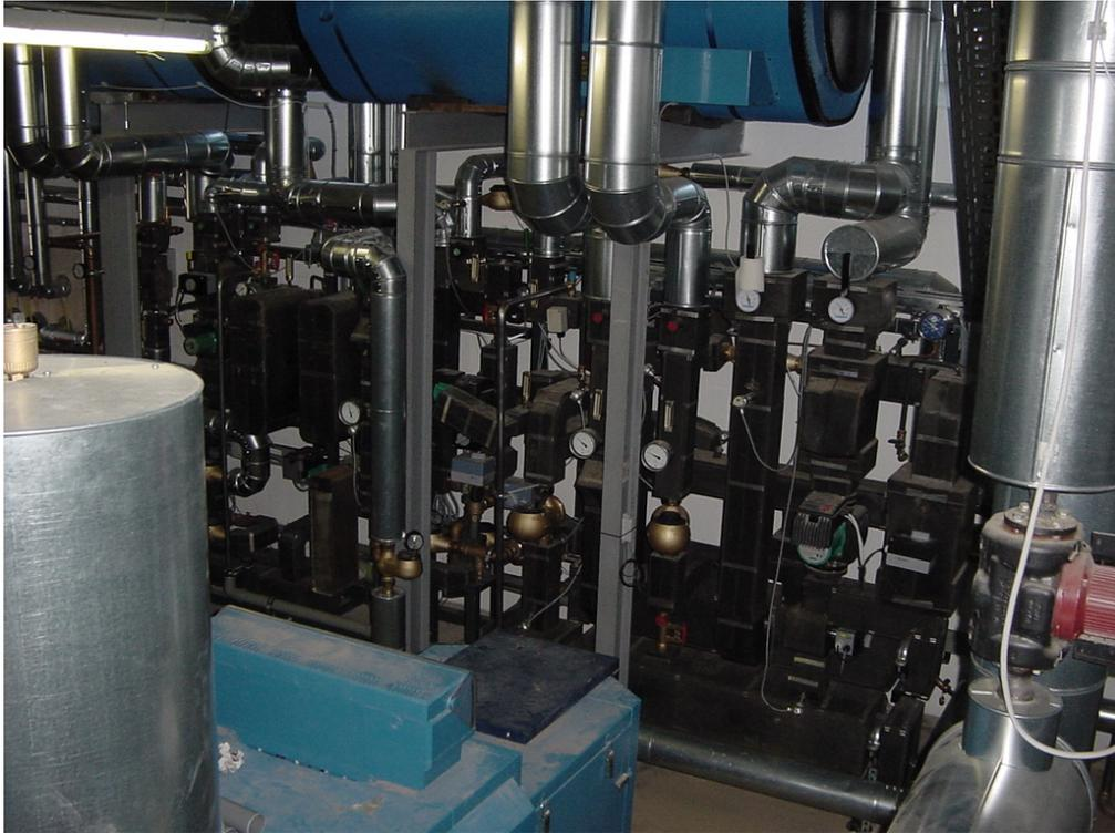
Abb. 033 Ansicht der Kompaktstation Solvis Zentro. Die liegenden Trinkwasserspeicher sind über der Station angeordnet. Am linken Bildrand sind, aufsteigend, die Leitungen zum Kollektorfeld, in Bildmitte die Leitungen zum Kessel und rechts die Leitungen zu den Heizkreisen zu sehen (Foto: TU Ilmenau 2007)
