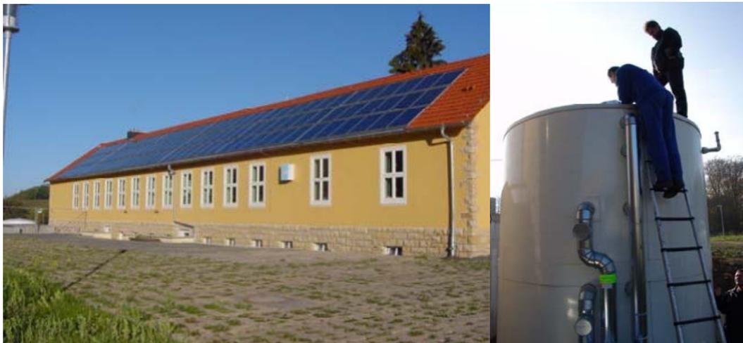
Abbn. 026 Ansicht des Kollektorfeldes / 15 m<sup>3</sup>-GFK Wärmespeicher (Quelle: Foto J. Bühl Ilmenau 2006)
