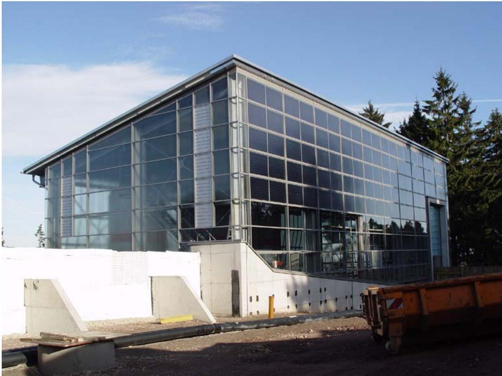
Abb. 029 Ansicht der Südfassade des Heizhauses mit den installierten Kollektoren
