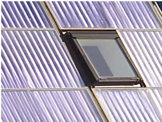
Abb. 042 Detaillösung Wohndachfensterintegration in das Kollektorfeld (Foto: TU I FG TFD 2009)
