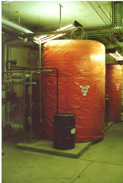
Abb. 002 Solarspeicher (2 x I) im Keller (Foto: TU Ilmenau FG TFD 2000)
