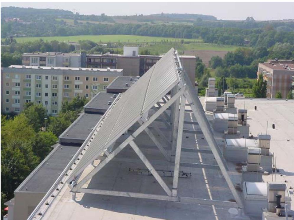
Abb. 024 Aufständering der Kollektoren (Stahlkonstruktion) auf dem Flachdach. Die Neigung beträgt  $45^\circ$  (Foto: J. Bühl Ilmenau 2002)
