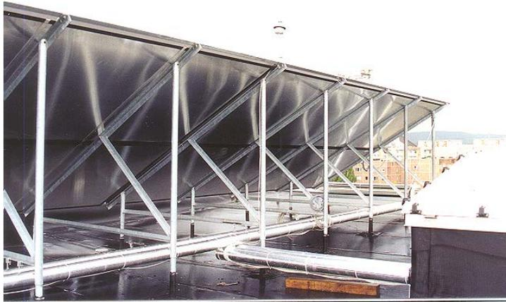
Abb. 006 Detailansicht des Kollektorfeldes und der – Aufständering
