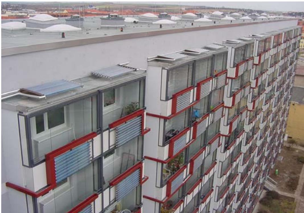
Abb. 017 Teilansicht des Kollektorfeldes (in den roten Verkleidungen ist die Verrohrung der Kollektoren untergebracht. Die Sammelleitungen der Stränge sind unter der Fassadenisolation nach oben in den DrempeI geführt)
