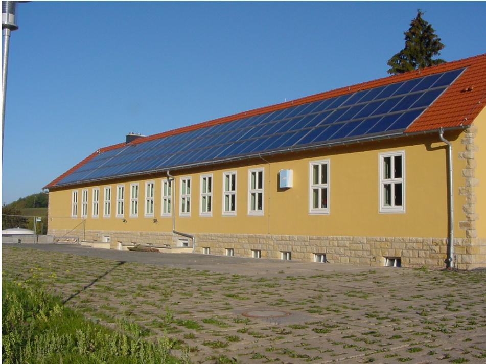
Abb. 031 Ansicht des Südflügels mit dem in die Dachhaut ("indach") integriertem Kollektorfeld. Im hinteren Teil des Gebäudes (links) ist im Keller die Technikzentrale untergebracht. (Foto: J. Bühl Ilmenau 2006)
