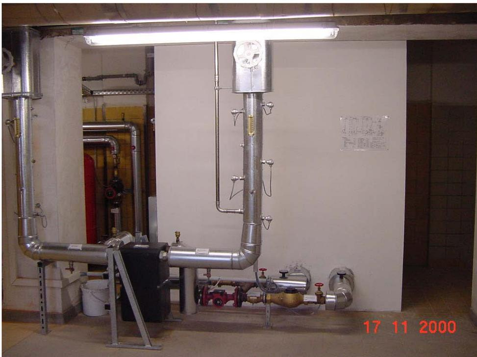
Abb. 016 Ansicht des Pufferspeichers der Anlage im Haustechnikraum der Inneren Medizin (quadratischer kellergeschweißter Niederdruckspeicher, die Verkleidung des Isoliermantels besteht aus Gipskartonplatten) (Foto TU Ilmenau FG TFD 2001)
