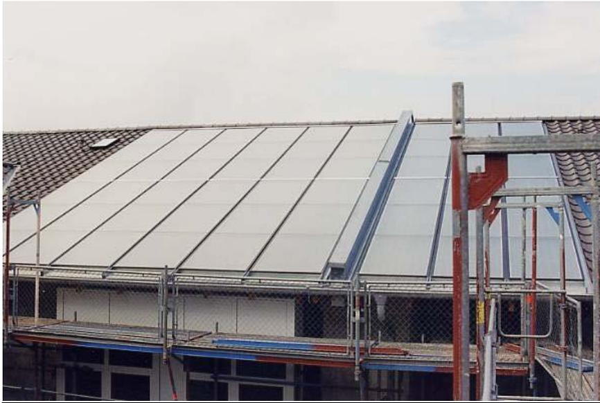
Abb. 013 Ansicht des östlichen Teilfeldes auf dem Schrägdach des Neubaus (Foto: TU Ilmenau FG TFD 2001)
