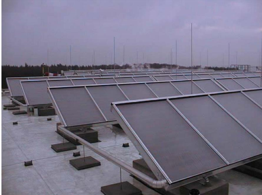
Abb. 011 Ansicht des West-Daches mit 153 m<sup>2</sup> Kollektorfläche
