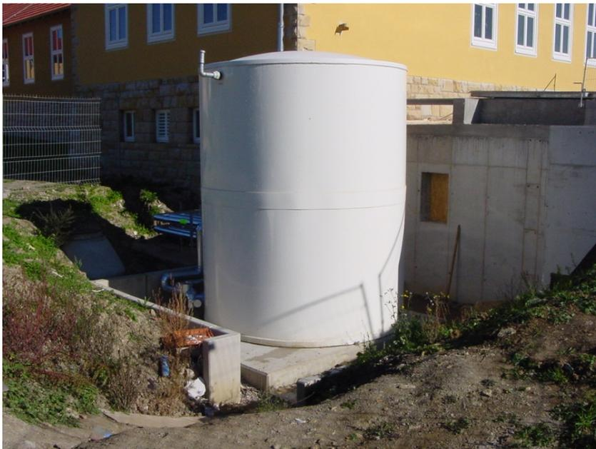
Abb. 032 Ansicht des drucklosen Solarpufferspeicher aus Glasfaserverstärktem Kunststoff (GFK). Es stehen 14 m<sup>3</sup> Volumen zur Verfügung (Foto: J. Bühl Ilmenau 2006)
