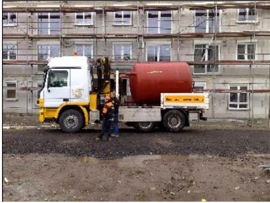
Abb. 040 Anlieferung des Wärmespeichers auf der Baustelle (Foto: TU I FG TFD 2009)
