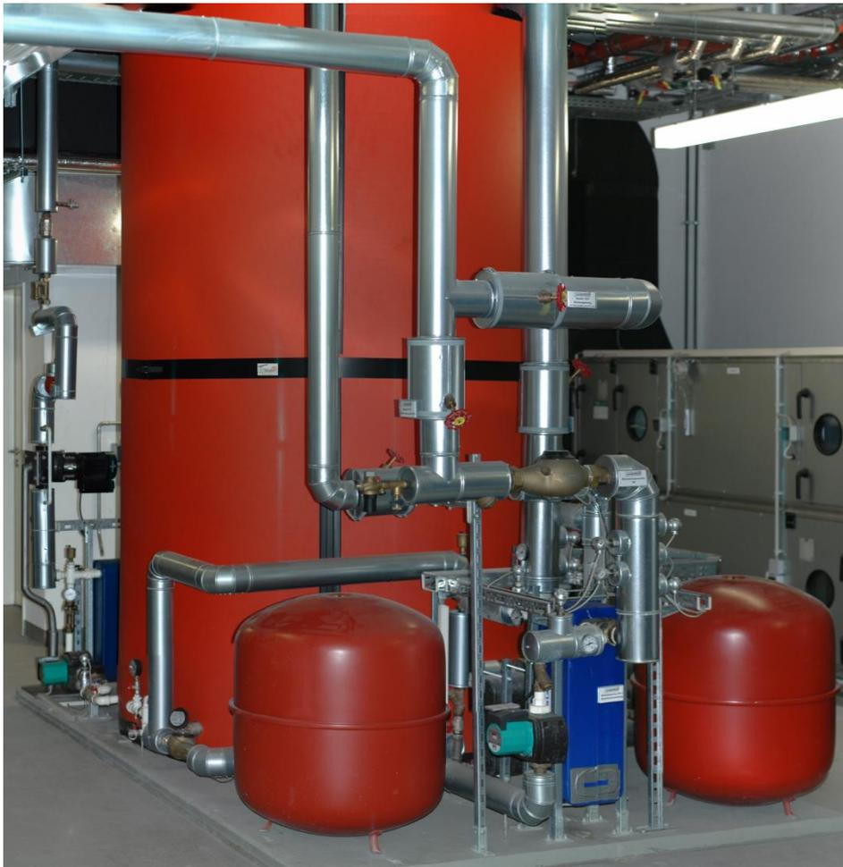
Abbildung 105 Anlagenansicht mit Pufferspeicher der Solaranlage in Sonneberg
