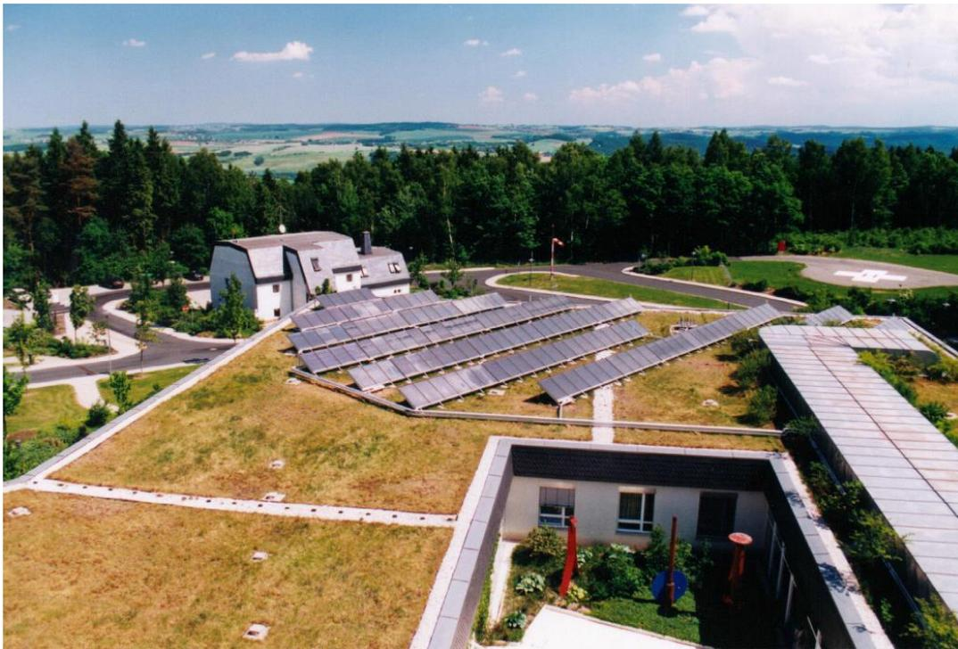
Abbildung 21 Kollektorfeld auf dem Flachdach des Kreiskrankenhauses Kirchberg [10]
