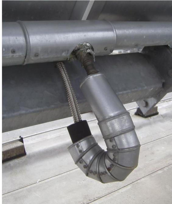
Abbildung 128 Ungünstiger Kollektoranschluss mit Wellrohr im kleinen Biegeradius
