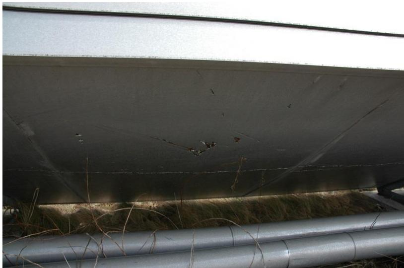
Abbildung 65 oben: saubere Kollektoren, unten: Vogelfraß an der Isolierung
