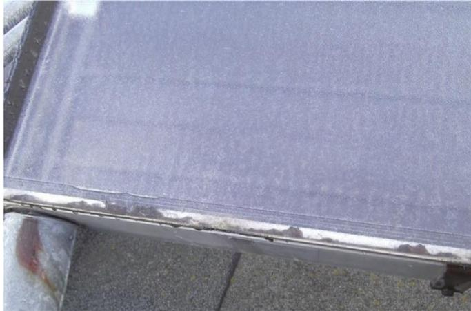
Abbildung 9 Grüner Schlick zwischen Glasabdeckung und Rahmen an den Flachkollektoren in Jena-Lobeda
