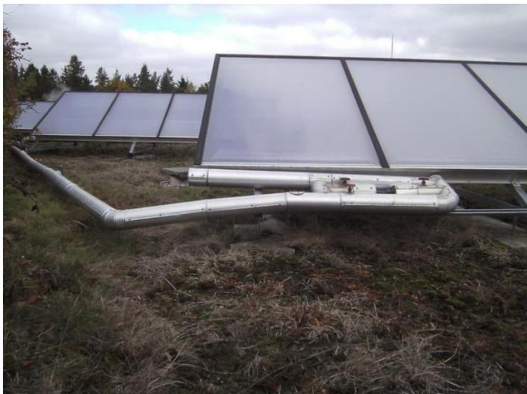
Abbildung 25 verformte Kollektorkreisleitung
