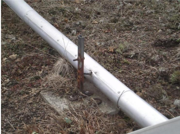
Abbildung 24 durchhängende Kollektorkreisleitung
