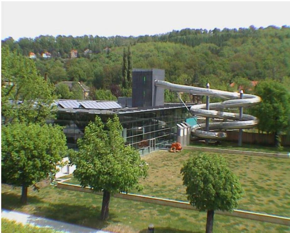
Abbildung 76 Geibeltbad in Pirna. Solarkollektoren auf Schwimmhallendach [16]
