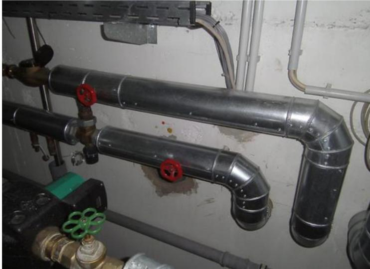
Abbildung 26 Undichtiges Ventil in der Zirkulationsvorwärmung
